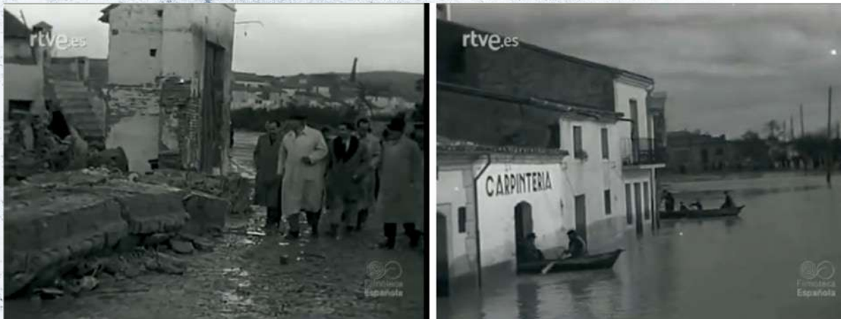
Figura 4. Visita del gobernador civil de Córdoba, Alfonso Ortí, y viviendas derruidas por la inundación (izquierda). Vecinos sobre barcas abandonan locales y viviendas entre calles y plazas inundadas (derecha). Imágenes extraídas del vídeo relativo al NO-DO nº 266 B de la Filmoteca Española de RTVE.
